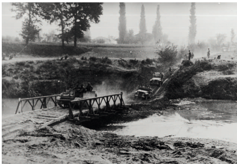
Polacy i Gurkhowie przekraczają rzekę Idice na moście Bailey. Jako pierwszy jedzie transporter opancerzony Universal Carrier, a za nim samochody Willys MB FOT. NARODOWE ARCHIWUM CYFROWE (WWW.NAC.GOV.PL)
