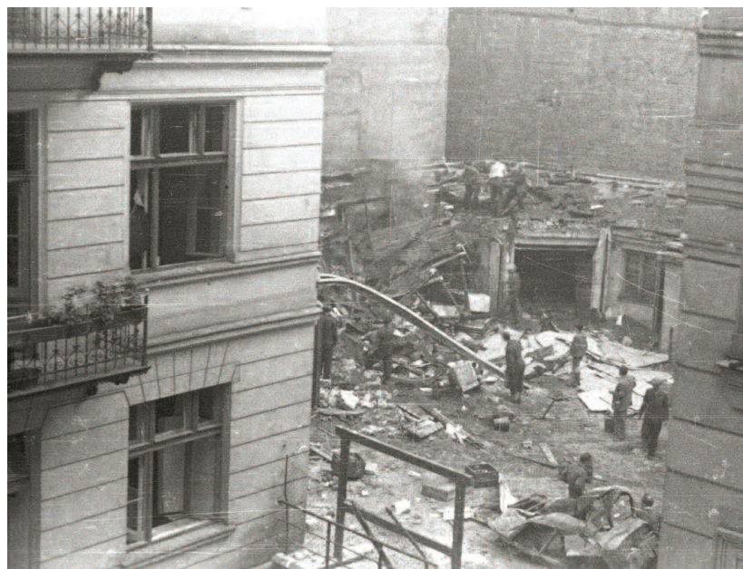
Podwórze kamienicy przy ul. Kilińskiego. Odgruzowywanie budynku zniszczonego w wyniku eksplozji niemieckiego nosiciela ładunków wybuchowych, 13 sierpnia 1944 r. FOT. MUZEUM POWSTANIA WARSZAWSKIEGO
