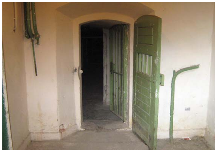
Korytarz więzienia w Rawiczu FOT. ARCHIWUM SŁUŻBY WIĘZIENNEJ
