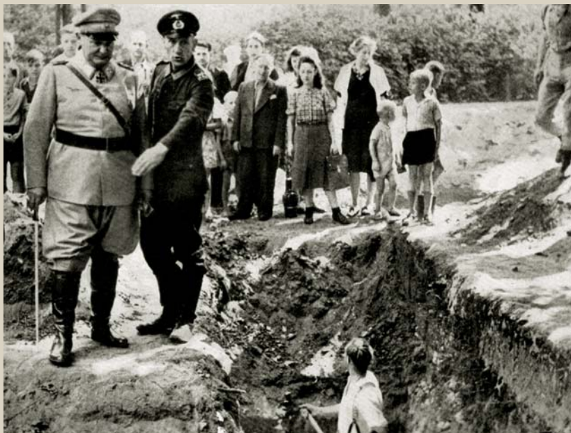
Marszałek Rzeszy Hermann Göring (drugi z lewej) przeprowadza inspekcję budowy schronów przeciwlotniczych. Obok: gen. Bruno Loerzer FOT. ETEL LANGE, NARODOWE ARCHIWUM CYFROWE (WWW.NAC.GOV.PL)
