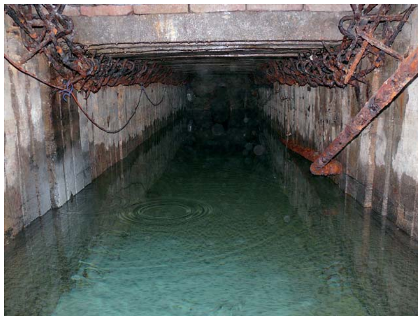
Fragment tunelu łączący Urząd Wojewódzki w Szczecinie z podziemiami Wałów Chrobrego albo prowadzący w stronę Dąbia FOT. ARCHIWUM URZĘDU WOJEWÓDZKIEGO W SZCZECINIE
