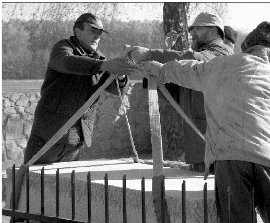
Prace budowlane pod auspicjami Rady OPWiM w Borszczówce
